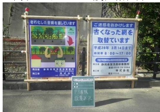
工事PR看板（静岡県）
