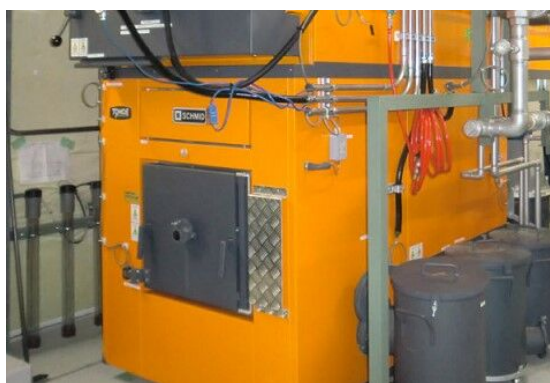
市営温泉「白樺荘」に導入(平成23年度)したバイオマスボイラーと燃料チップ
