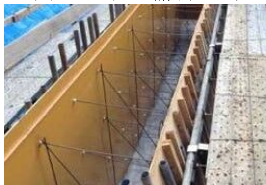
県産材合板型枠（静岡県）
