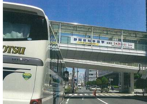
【設置場所：駿河区南町】
