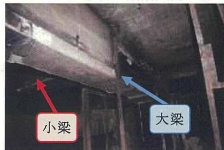
写真43 大梁及び小梁の状況
