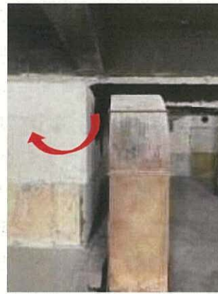
写真 63 ダクトを囲む壁面の空気流入箇所 写真 64 ダクトを囲む壁面の空気流入箇所
