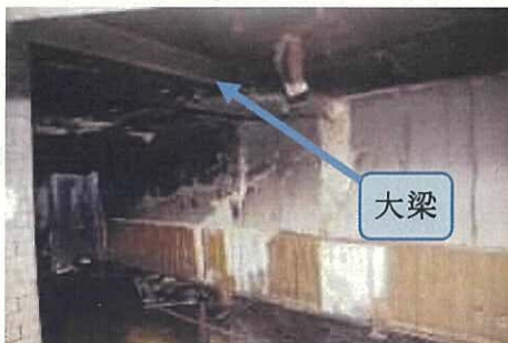
写真42 空室内の大梁
