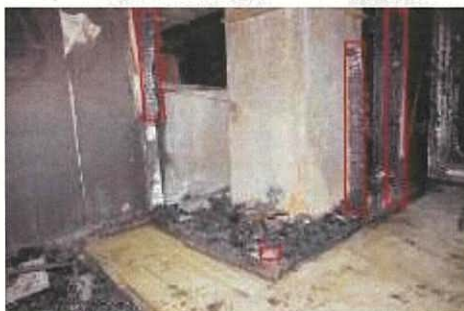
写真46 ダクトを囲む壁面の焼損状況 写真47 ダクトを囲む壁面の焼損状況
