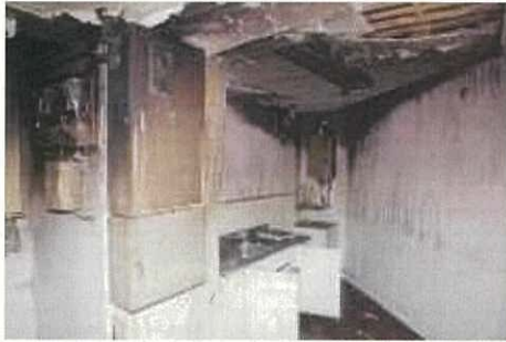
写真23 給湯室の状況 (図19②)
