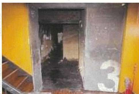
写真 22 3階フロア入口(図 19①)
