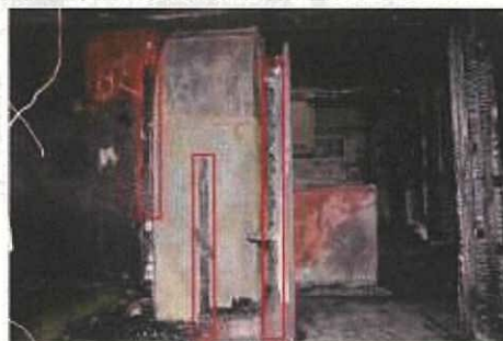
写真46 ダクトを囲む壁面の焼損状況 写真47 ダクトを囲む壁面の焼損状況
