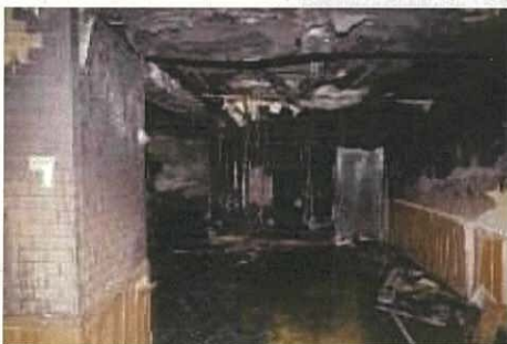
写真25 空室②の状況 (図19④)
