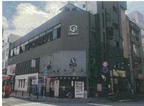
建物北東側から撮影
