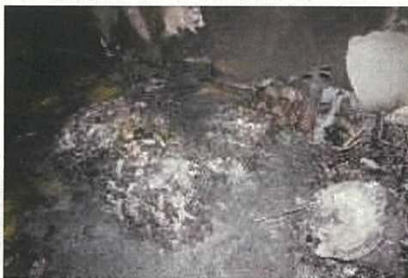
写真 38 火点室内の状況
