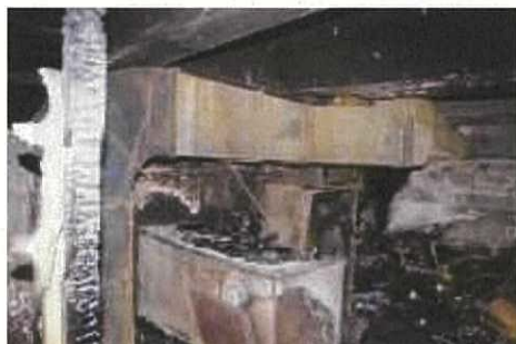
写真44 火点室のダクトの状況
