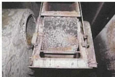
写真45 ダクト繋ぎ目部分の状況
