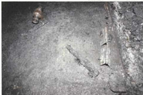
写真 29 休憩室出入口ドア周辺の状況
