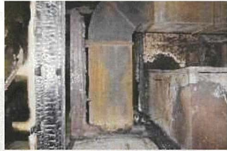
写真 28 ダクト周辺の状況 (図 19⑦)
