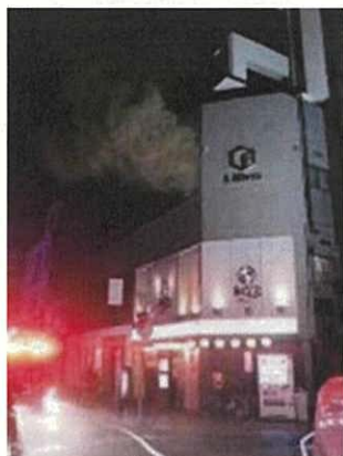
写真 16 火元建物東側
