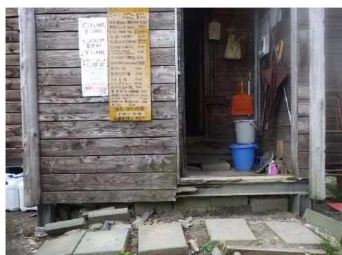
山小屋修繕箇所
