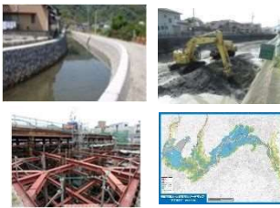
河川改修・下水道施設整備（建設局）【136,000千円】 上下水道局【3,880,911千円】 巴川洪水ハザードマップ作成事業（総務局）【7,515千円】
