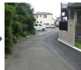
狭あい道路拡幅整備事業 実施後
