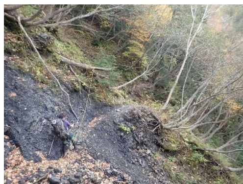
登山道崩壊箇所
