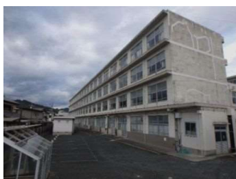
校舎改修前(例)
