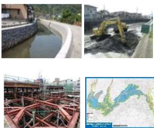
河川改修・下水道施設整備（建設局）【81,000千円】 上下水道局【4,534,285千円】 洪水ハザードマップ作成事業（総務局）【13,040千円】
