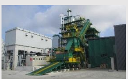
木質バイオマス発電
