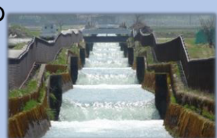
落差を有する農業用水路
