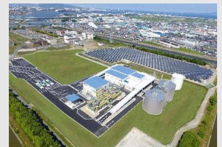
国内最大規模の豊橋市バイオマス利活用センター
