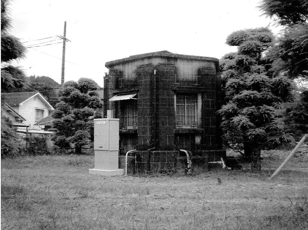
牛妻水源地（集水井）
