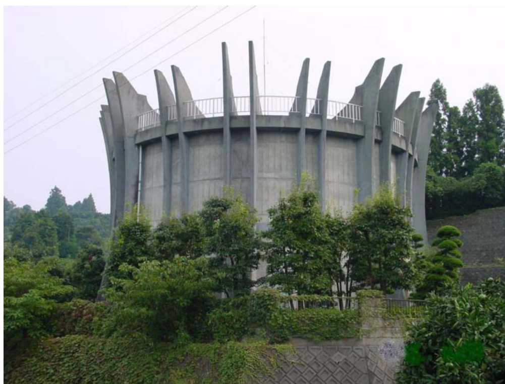
富士見が丘配水地
