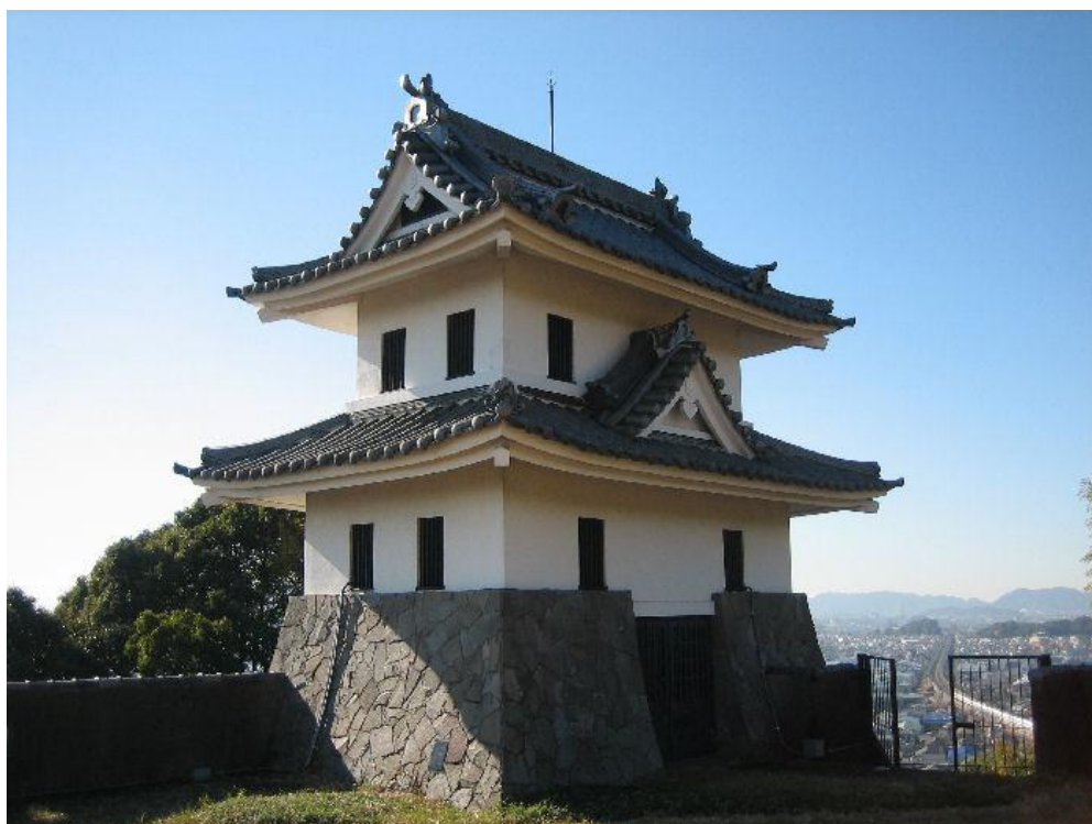
大平山配水池
