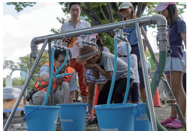
耐震性貯水槽の使用 断水体験 (H30.8 小鹿一丁目新町)
