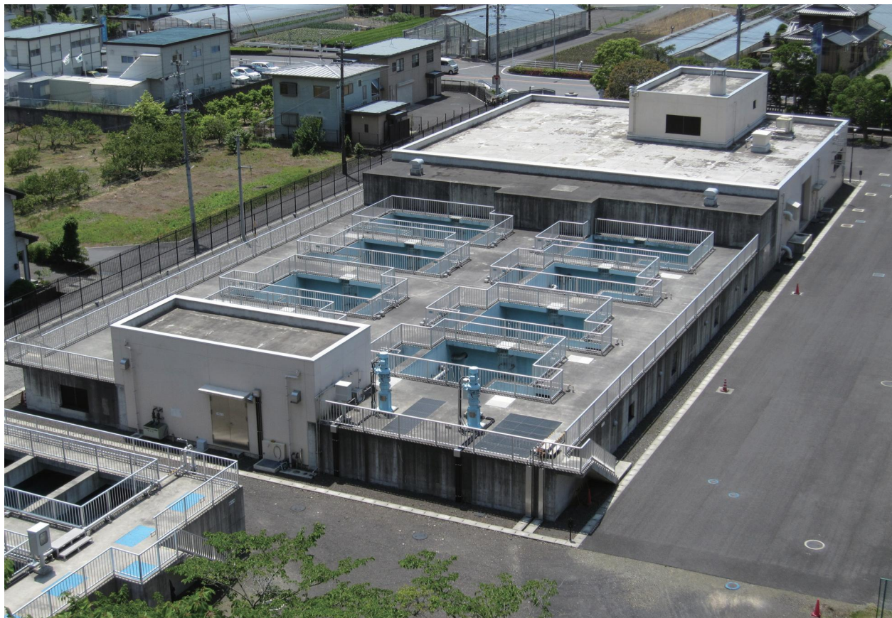
急速ろ過施設
