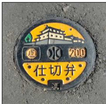
仕切弁ボックス鉄蓋 I 型・仕切弁ボックス鉄蓋 II 型
