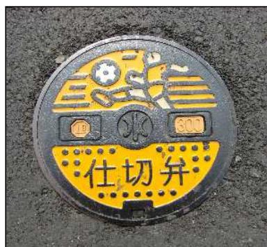
仕切弁ボックス鉄蓋 I 型・仕切弁ボックス鉄蓋 II 型
